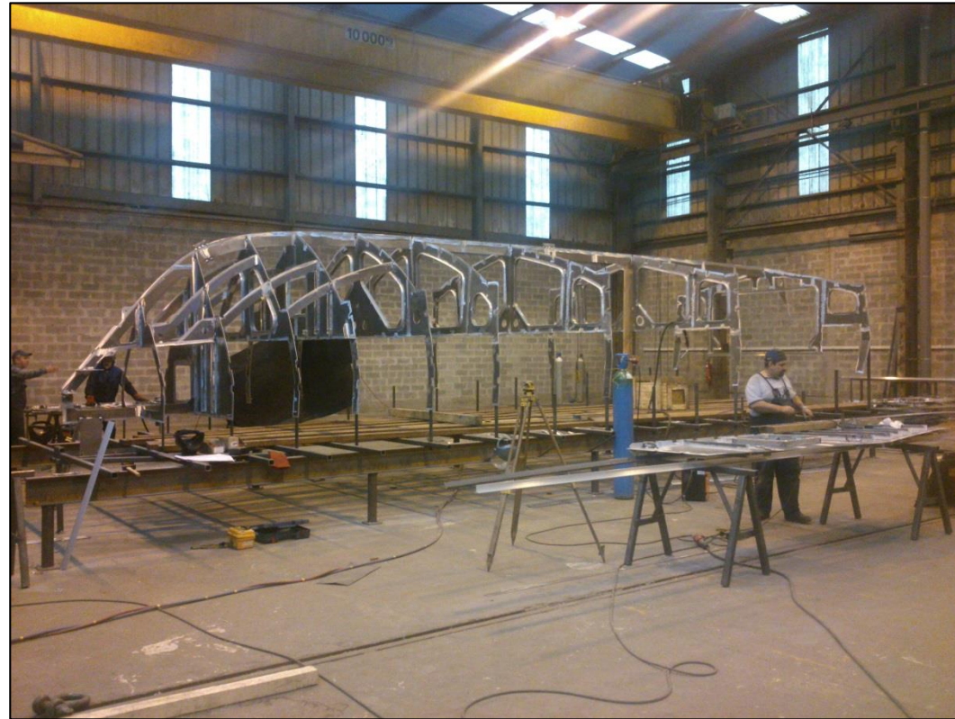
Début de la construction de la première vedette (juillet 2014)
