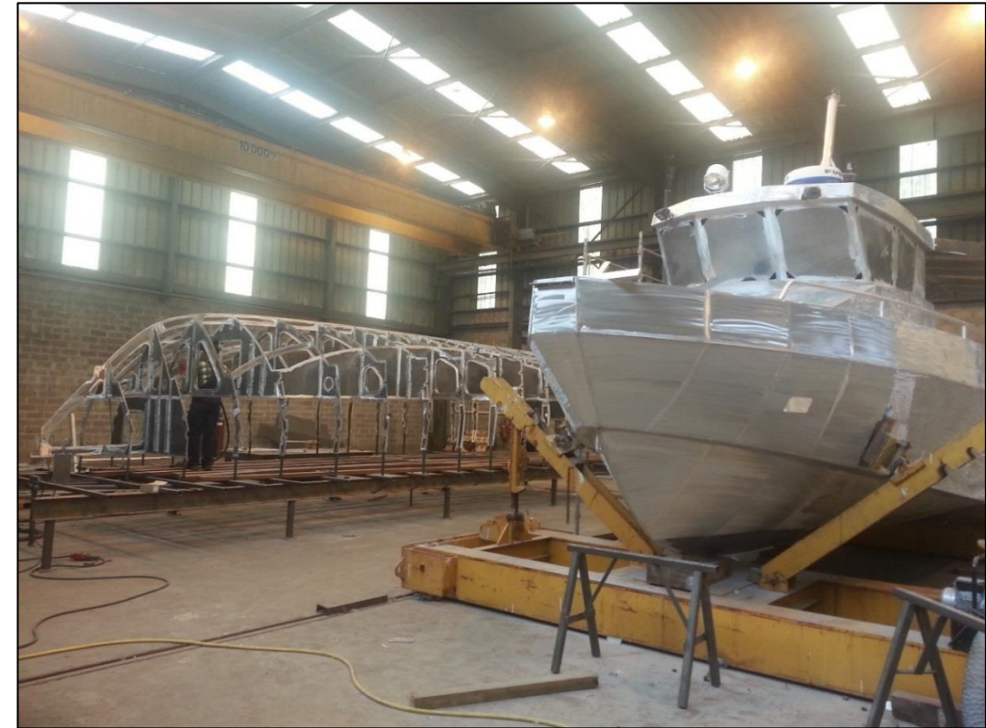
Début de la construction de la seconde vedette (septembre 2014)
